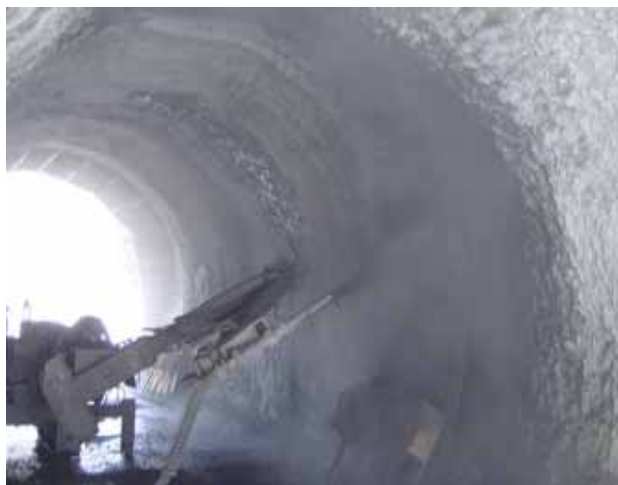
写真1 模擬トンネルを用いた吹付け試験の様子
