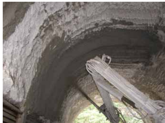
吹付けコンクリートの模擬施工状況
