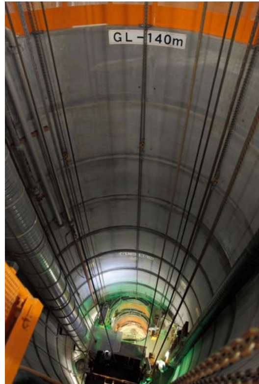
■ 東立坑深度140m以深の施工状況
