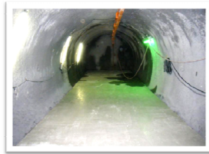
坑道仕上がり状況
