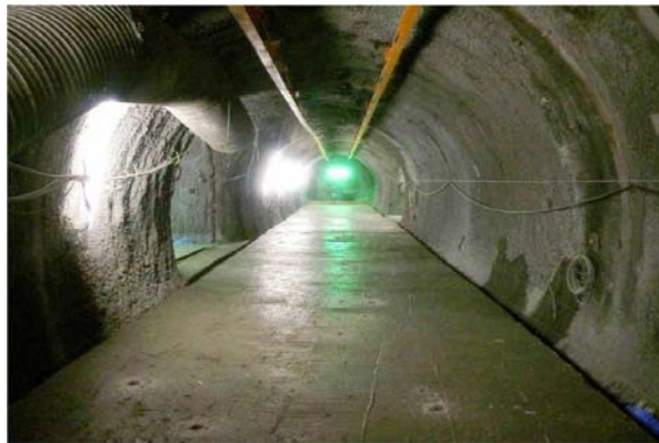
完成直後の調査坑道
