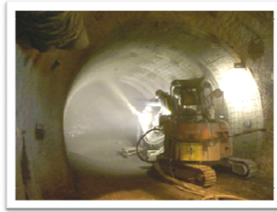
吹付け施工の様子
