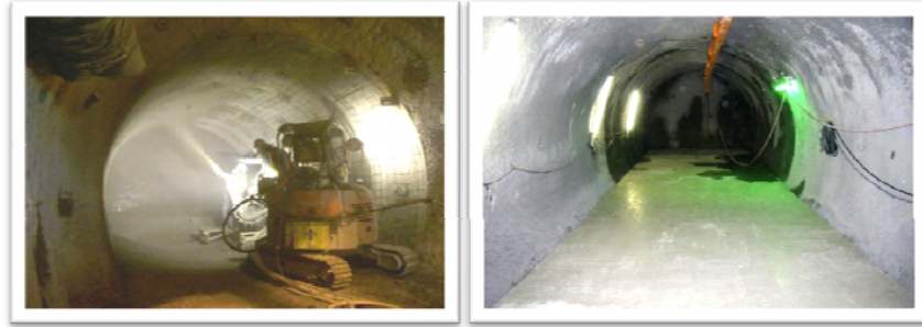
吹付け施工の様子
