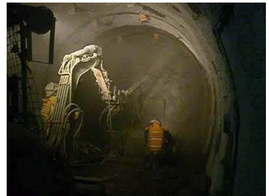
140m研究アクセス坑道を用いたHFSC吹付け試験の様子(幌延)
