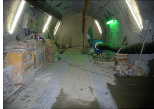
東立坑より南南東方向へ掘削【小型試錐座】(南)
