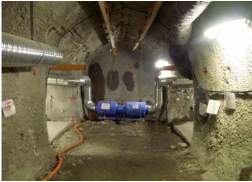
東立坑より北北西方向へ掘削
