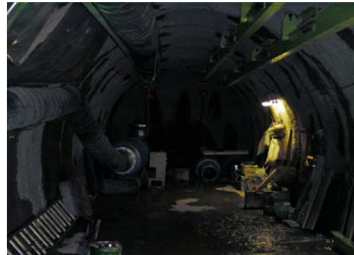
換気立坑より南南東方向へ掘削
