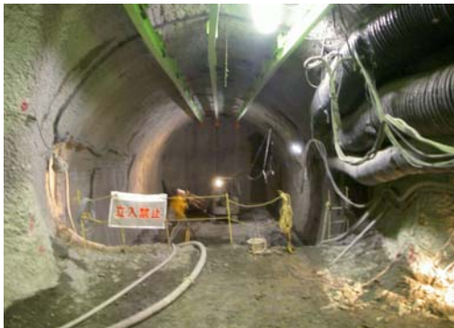
換気立坑より西方向へ掘削【大型試錐座】
