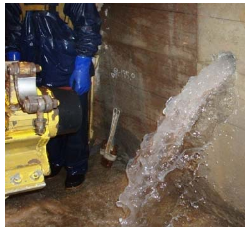
湧水状況（湧水量約500ℓ/min）
