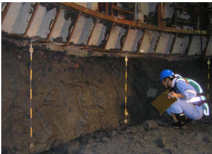
坑道壁面観察
