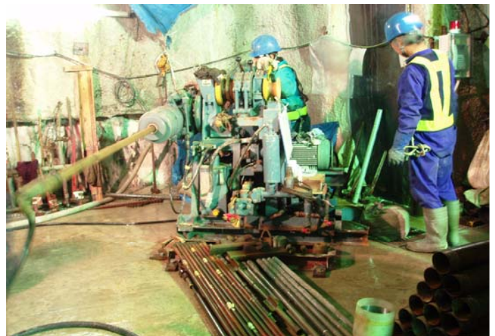
ボーリング調査 (200mボーリング横坑)
