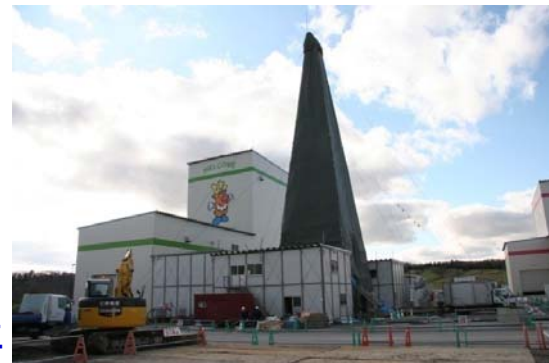
東立坑近傍におけるボーリング調査 (平成20年11月6日現在の状況)
