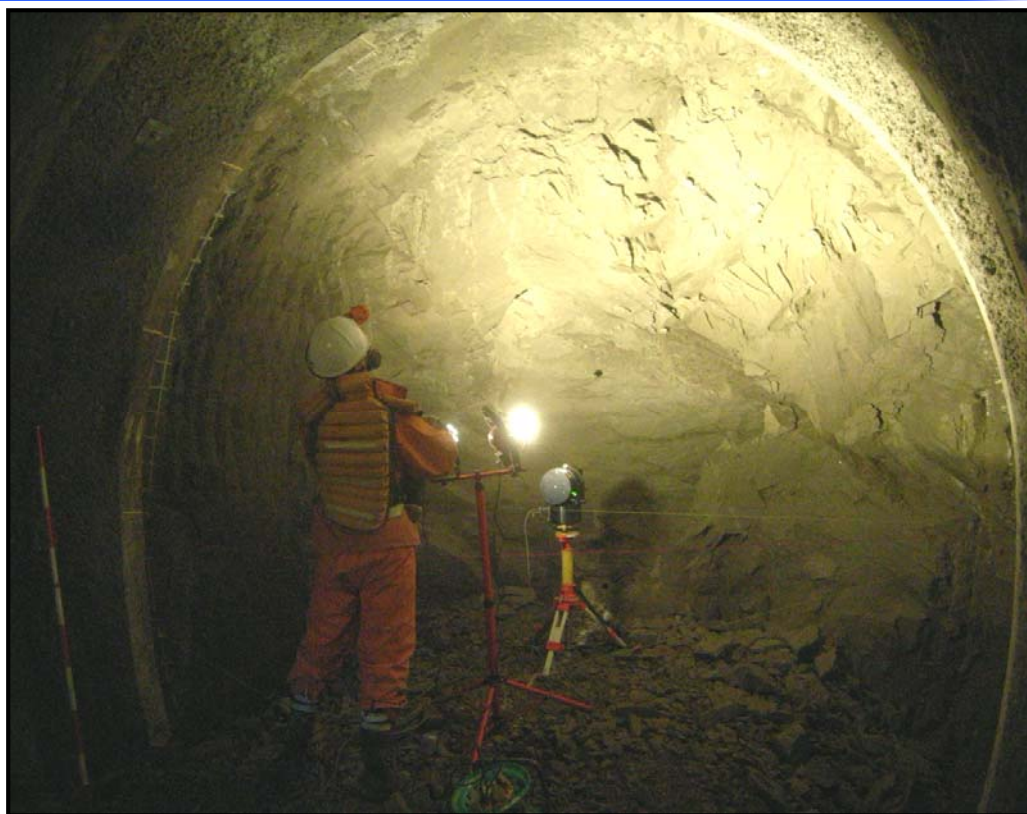
換気立坑：深度140m（水平坑道）
