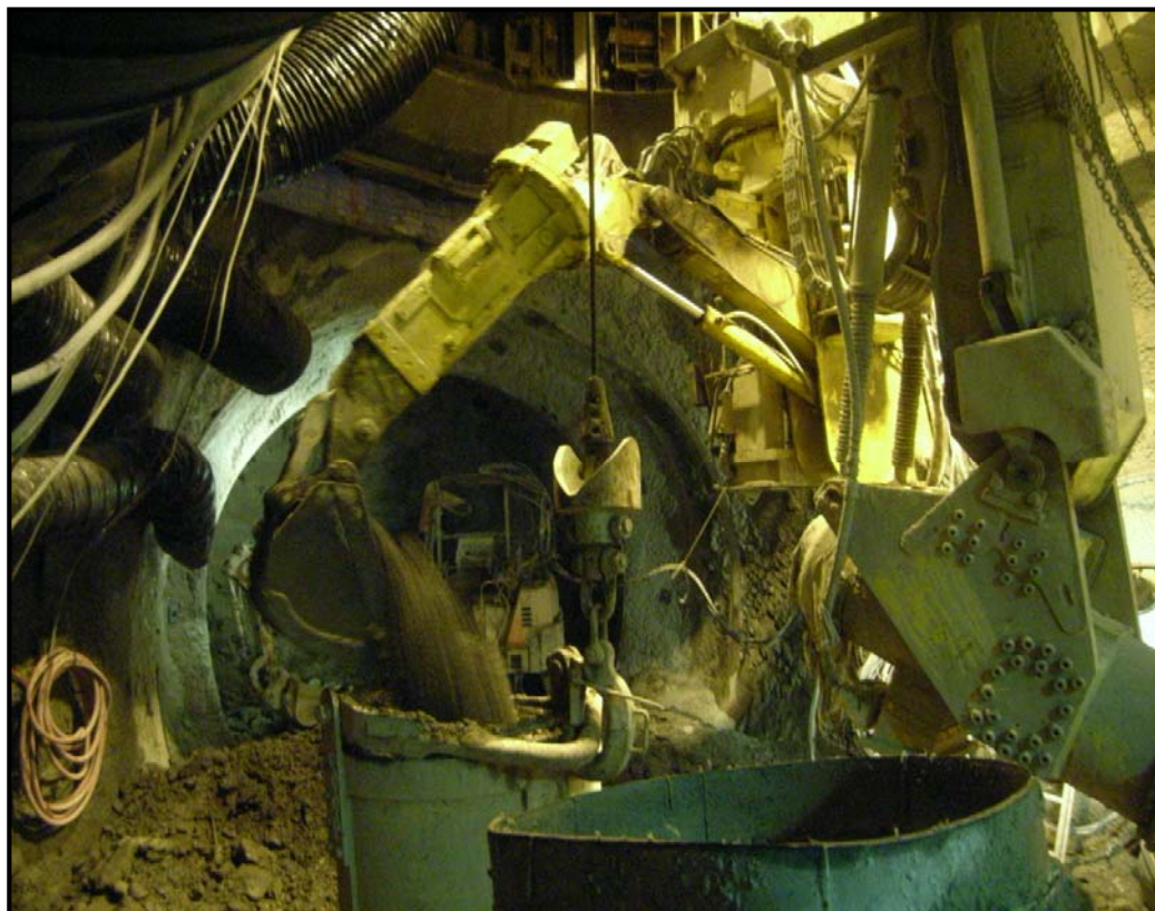
積み込み機による掘削土(ズリ)の積み込み:換気立坑(深度140m)
