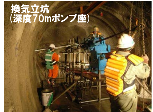
測定用ボーリング孔の掘削の様子
