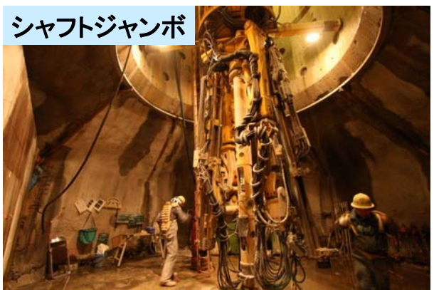
200 m予備ステージ貫通状況
