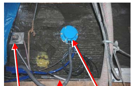
ロックボルト軸力計 多段式岩盤変位計 歪ゲージ(鋼製支保応力測定)
