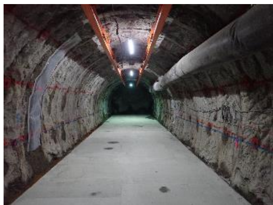
試験坑道6の掘削完了の様子
