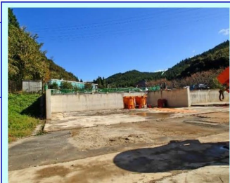
③主立坑巻上機室 :完了 2021.7.19
