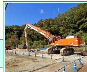
⑥コンクリートプラント :完了 2021.10.12
