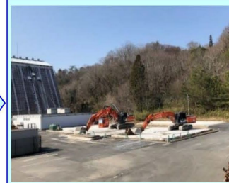
①管理棟・車庫棟 :完了 2021.2.12
