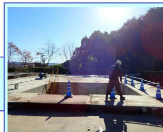
⑧換気立坑巻上機室 :完了2021.10.29
