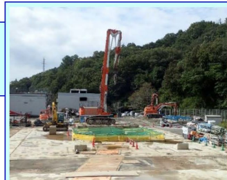
④主立坑防音ハウス :完了 2021.9.3
