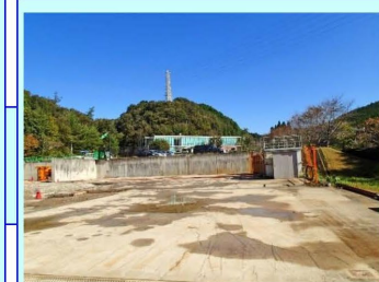
②排水処理設備 :完了 2021.7.2
