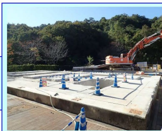
⑦受変電・非常用発電設備:完了2021.10.25
