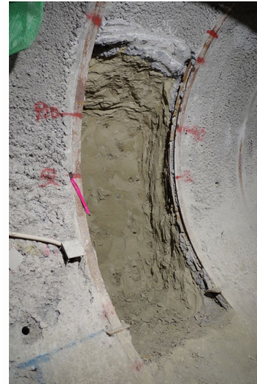
(a) 坑道側面に設けた切欠き部
