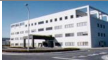
地層処分基盤研究施設(エントリー)
