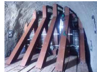
支保工建込み後の様子
