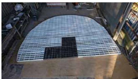
土留め壁の組立検査(地上)の様子
