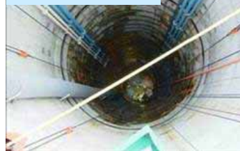
主立坑掘削状況
