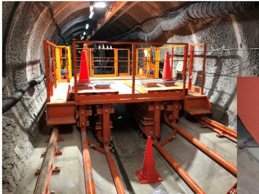
充填装置および充填状況（下部狭隘部）
