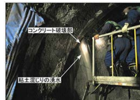
大量湧水発生状況
