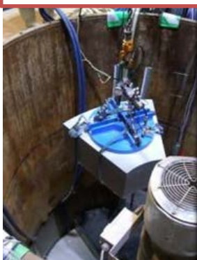
緩衝材ブロックの設置
