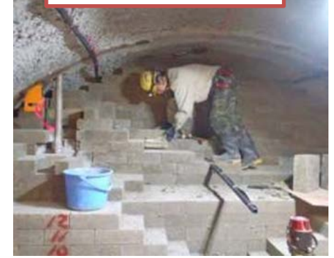
埋め戻し材ブロックの設置
