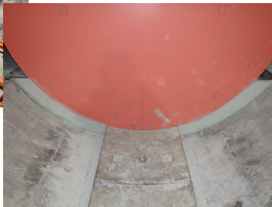
充填装置および充填状況(下部狭隘部)
