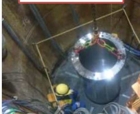
人工バリア性能確認試験 施工の様子
