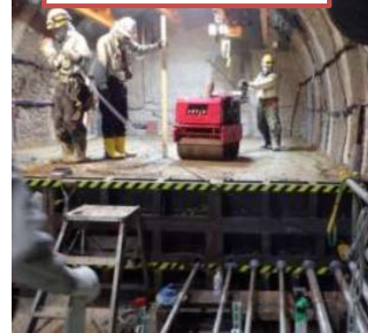
人工バリア性能確認試験 施工の様子
