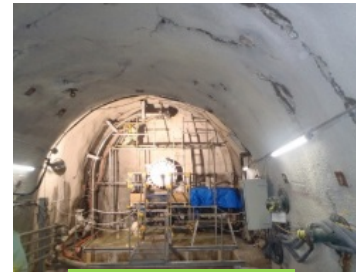
止水壁の設置
