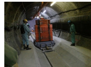
坑道内搬送・定置技術の要素試験
