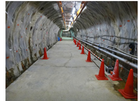
350m東周回坑道 (平成28年10月12日撮影)
