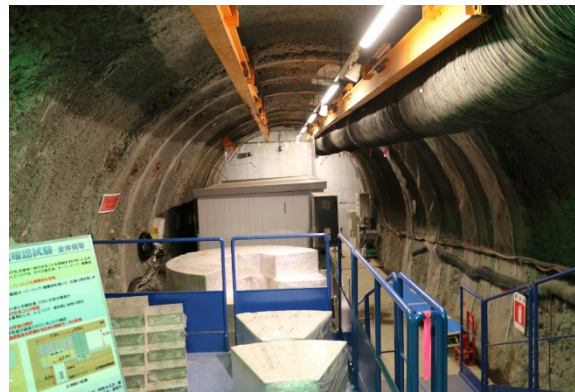
350m試験坑道4 (平成28年11月1日撮影)
