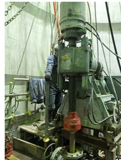
ボーリング孔の掘削の様子
