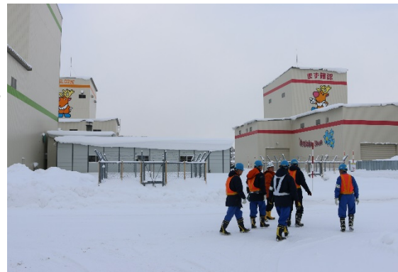
東立坑建屋北側 (平成28年1月12日撮影)
