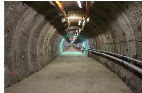
350m東周回坑道 (平成28年1月28日撮影)
