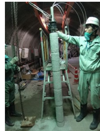
緩衝材設置状況
