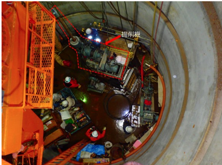
ボーリング孔掘削の状況 (東立坑坑底(380m))
