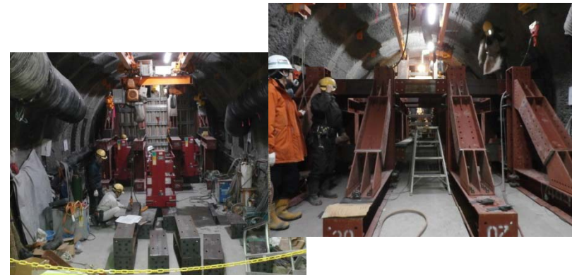
②型枠設置・控え材組立
