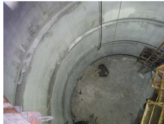
東立坑 380m坑底付近 (平成26年4月23日撮影)
