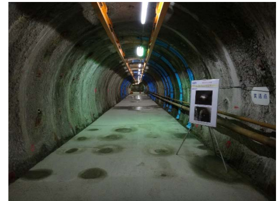
350m周回坑道(東) 平成25年10月9日貫通地点 (平成26年6月18日撮影)
