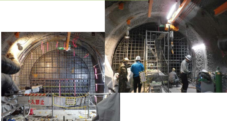
①鉄筋組立
