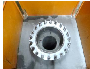
コンクリート支保
