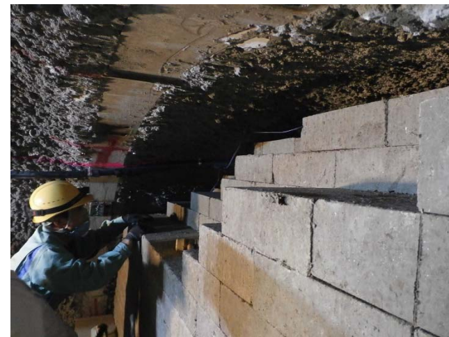
ブロック設置
