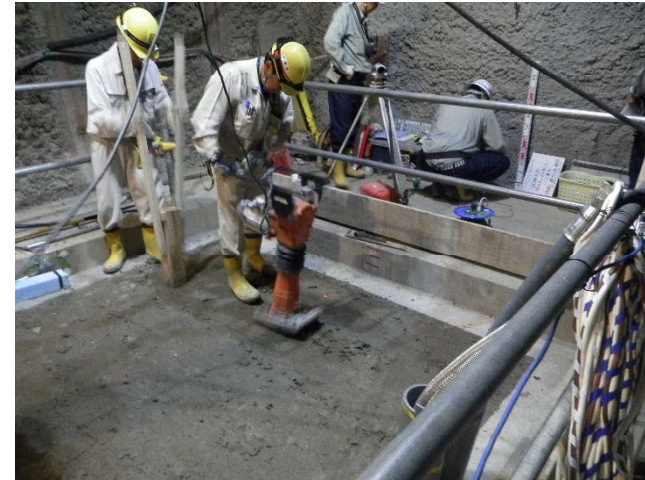
転圧締め固め
