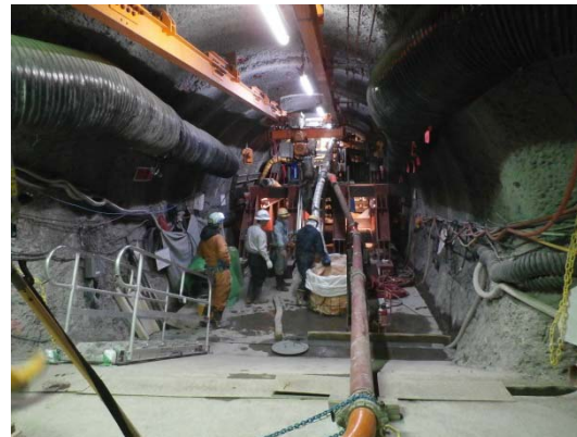
④打設状況
