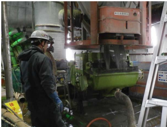
③地上で製造したコンクリートを東立坑350m地点に下ろしコンクリートポンプで試験坑道へ圧送
