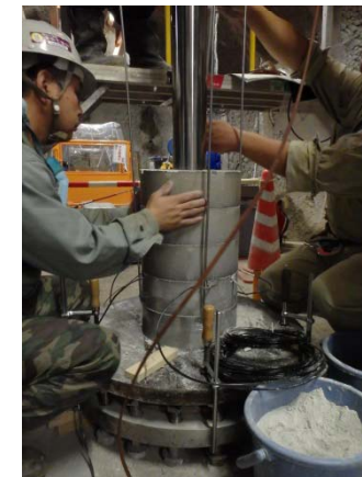
緩衝材・計測器設置状況
