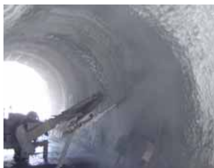
模擬トンネルを用いた吹付け試験の様子
