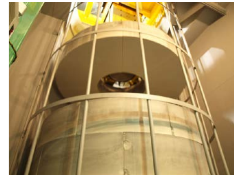
緩衝材定置試験状況
