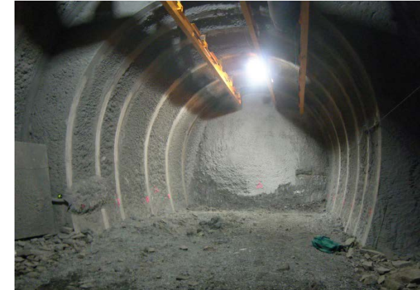
掘削状況(試験坑道4) (平成25年12月5日撮影)
