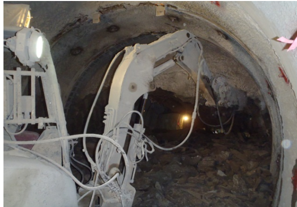
掘削状況 (深度350m周回坑道の貫通) (平成25年10月9日撮影)
