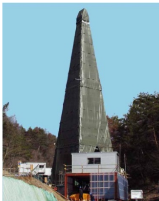
ボーリング調査
