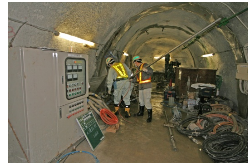
深度300m 11m計測横坑
