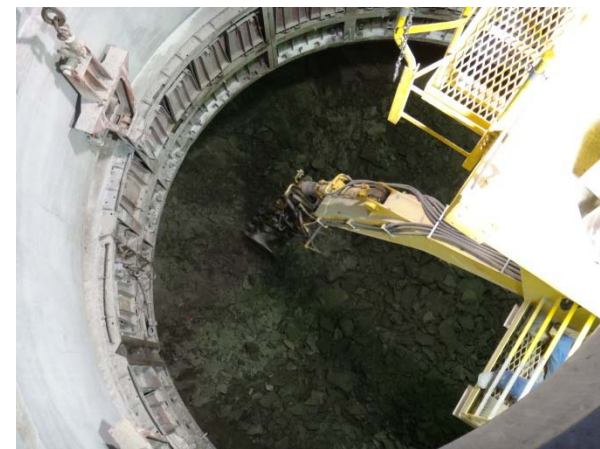
西立坑 (平成25年2月25日撮影)
