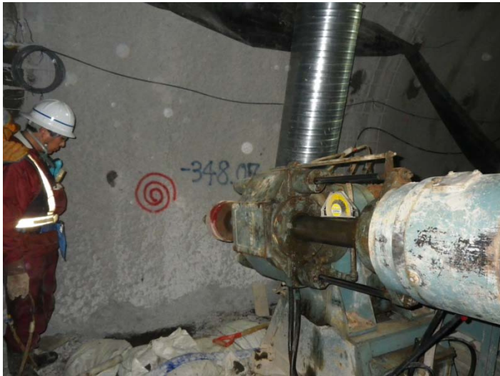
平成25年3月6日、坑道掘削影響・回復試験のためのモニタリングボーリング掘削を開始
