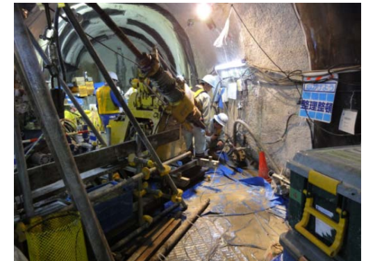
深度300mボーリング横坑 物質移動に関する調査研究 におけるボーリング調査
