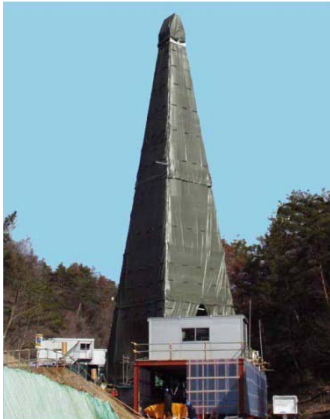
ボーリング調査
