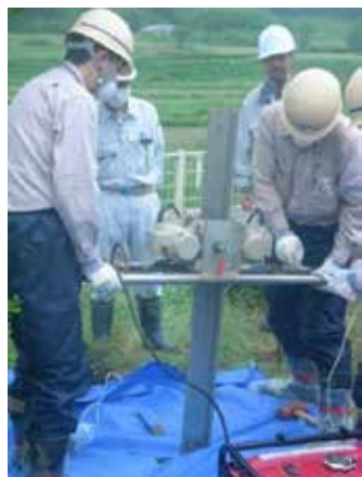
ジオスライサーによる掘削 (ハンディタイプ)
