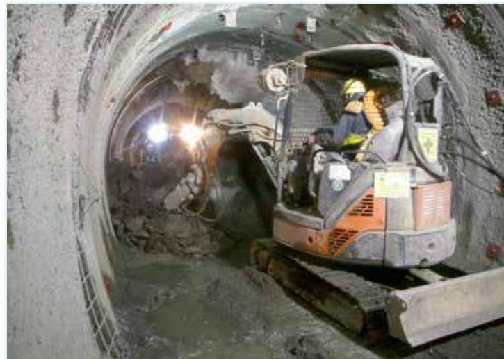
平成24年5月26日、深度350mの換気立坑と東立坑を結ぶ水平坑道が貫通
