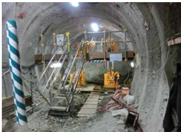
深度350m調査坑道 (平成24年8月24日撮影)
