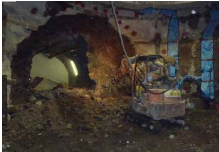
平成24年9月10日、西立坑と深度140m調査坑道が貫通
