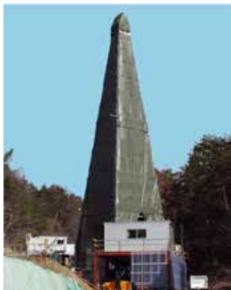
ボーリング調査
