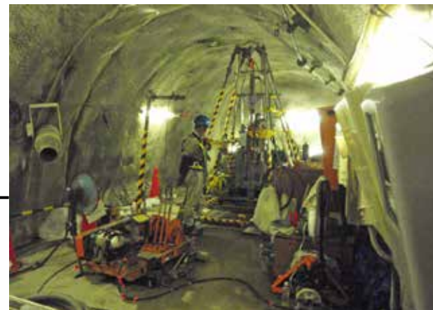
東濃地震科学研究所との施設供用 応力計設置のためのボーリング孔 (平成24年度掘削)
