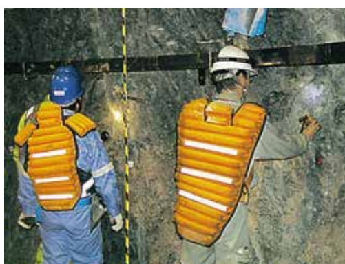
壁面地質調査
