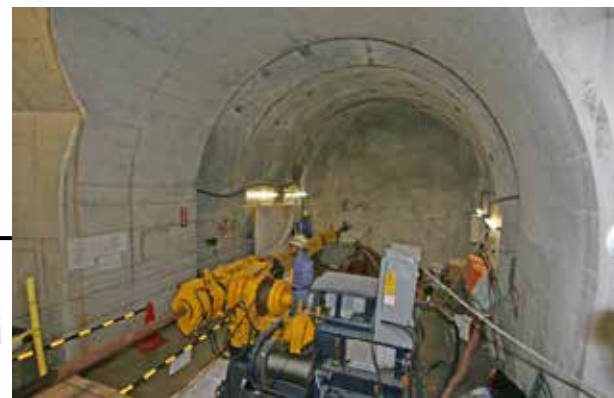
パイロットボーリング孔 (平成24年度掘削)
