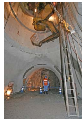
【換気立坑(深度500.2m)】
