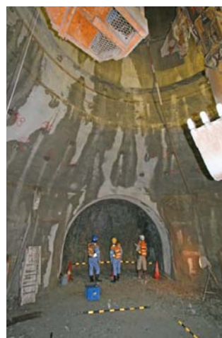
【主立坑(深度500.2m)】
