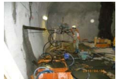
大型試験座での断層掘削 (換気立坑深度250m)
