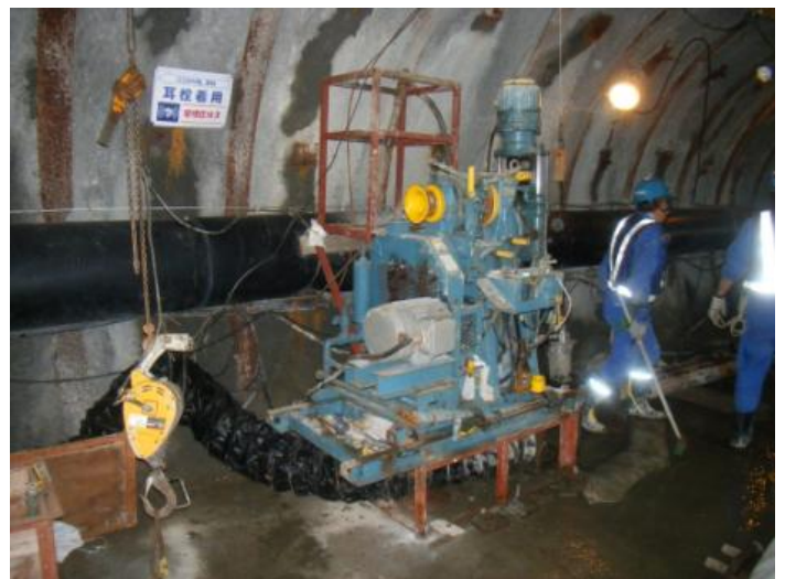
深度140m坑道における地圏環境研究所によるボーリング調査
