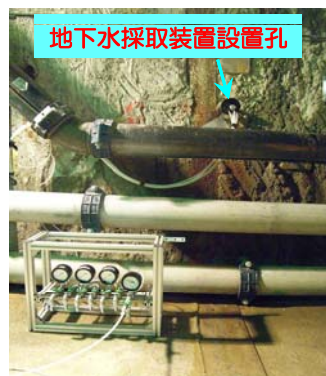
地下水採取装置設置
