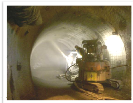
吹付け施工の様子
