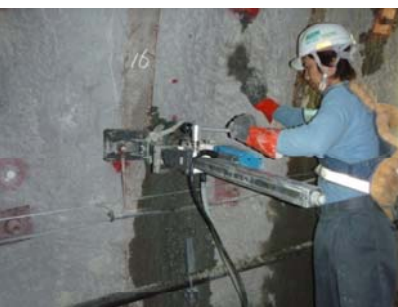
HFSC施工壁面からのコア採取
