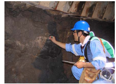
立坑壁面の地質観察状況
