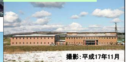
地上施設用地 (研究管理棟建設状況)
