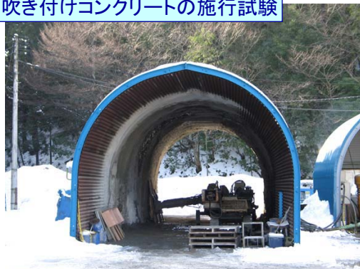
吹き付けコンクリートの施行試験
