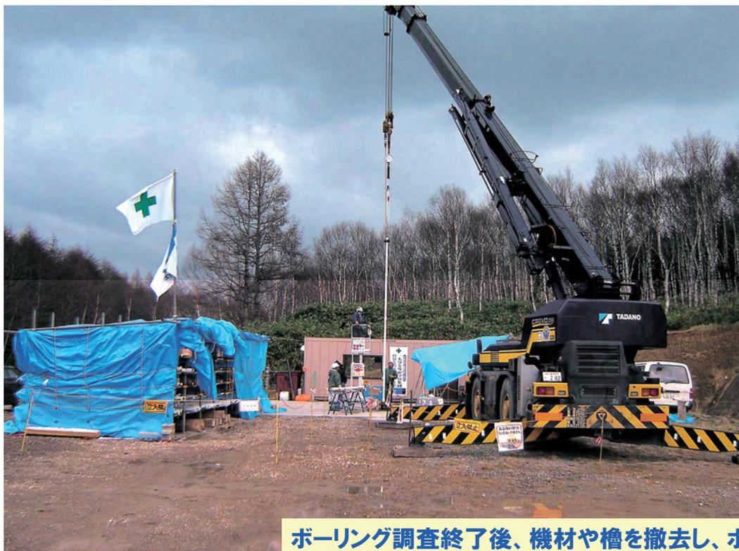
ボーリング調査終了後、機材や檣を撤去し、ボーリング孔内に地下水圧モニタリング装置を設置
