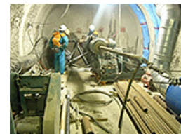
坑道内におけるボーリング調査
