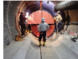
模擬PEMの設置
