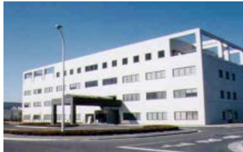
地層処分基盤研究施設(コールド施設)
