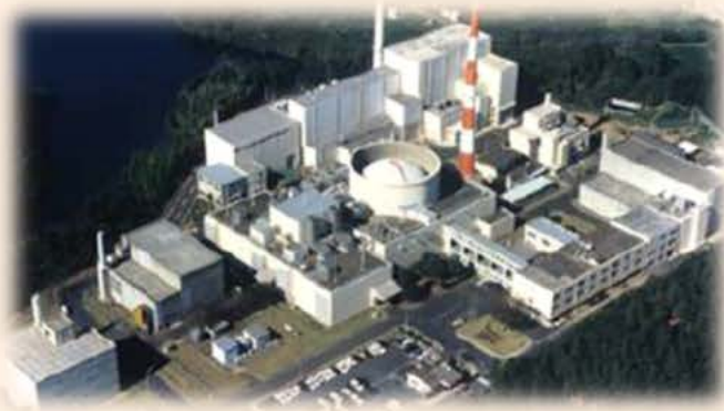
高速実験炉「常陽」
