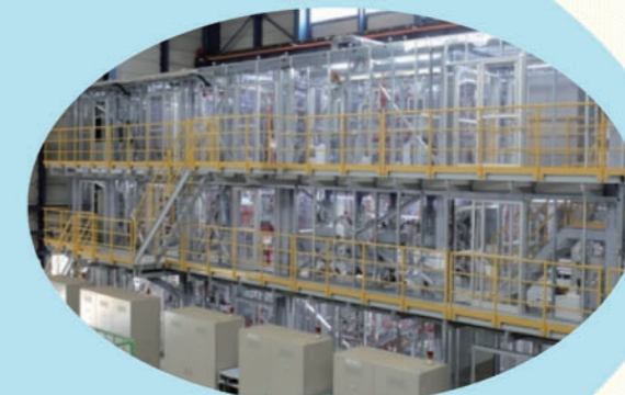
連続水素製造試験装置
