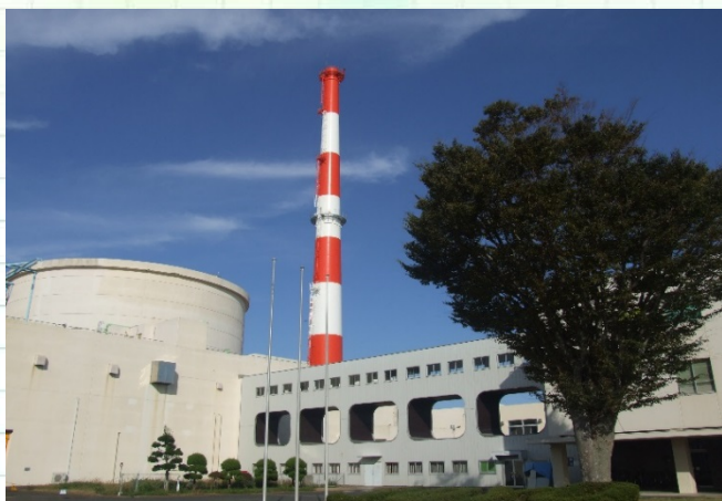
高速実験炉「常陽」
