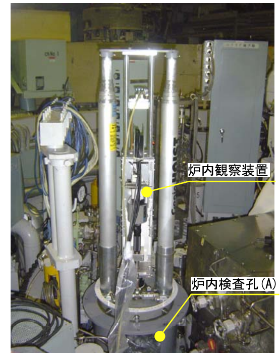
炉内検査孔 (A) での観察作業の状況
