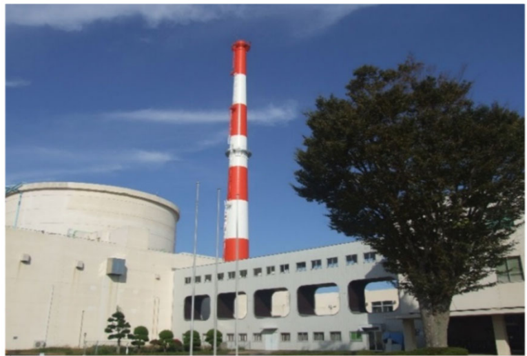
高速実験炉「常陽」
