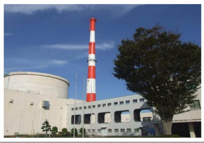
高速実験炉「常陽」
