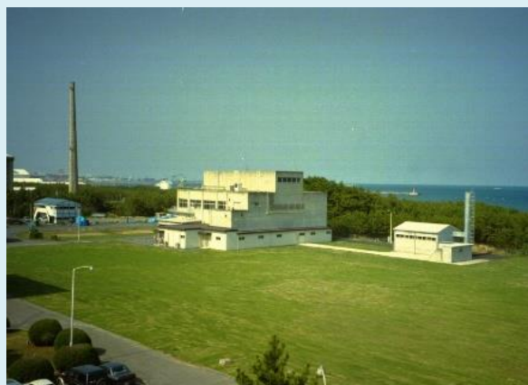
JPDRの解体後
