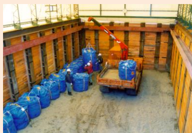
コンクリート等廃棄物の 定置作業状況
