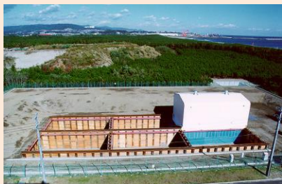
廃棄物埋設施設の外観
