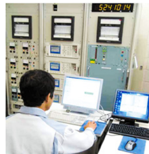
放射線モニタ 監視装置
