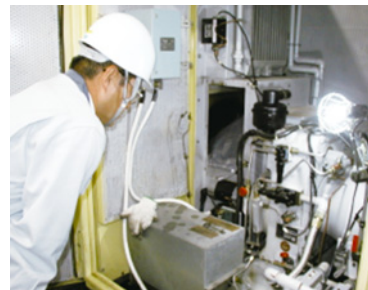
研究所の建物・電気・機械設備の補修・改修工事及び点検整備
