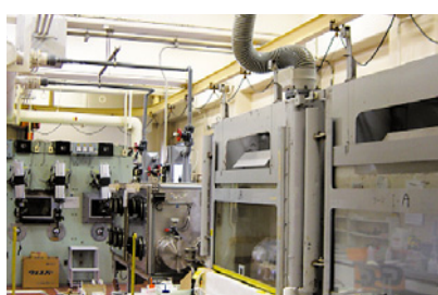
第4研究棟内部のフード、グローブボックス、鉛セル
