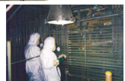
配管の解体作業
