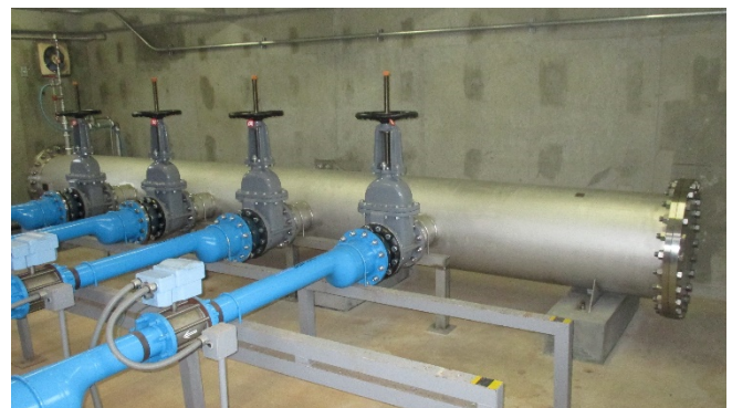
写真 2.10.3-2 上水ヘッダー更新後
