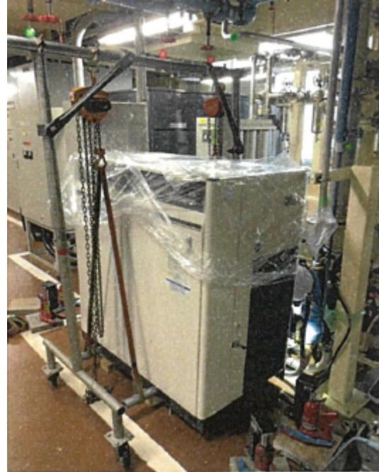
写真 2.1.13-2 空気圧縮機 更新後
