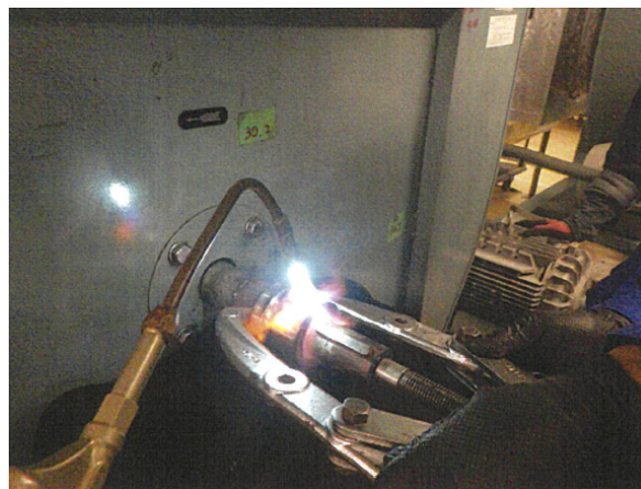
ベアリングユニット取外し作業状況
