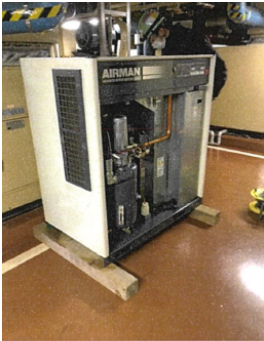
写真 2.1.13-1 空気圧縮機 更新前
