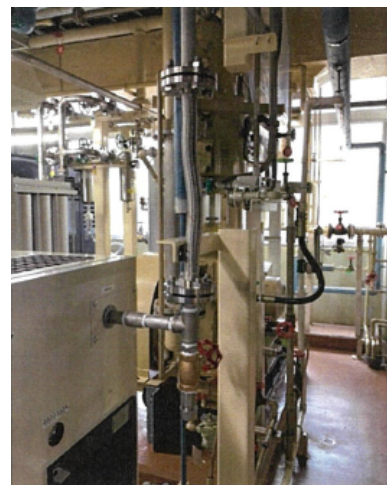
写真 2.1.13-2 空気圧縮機 更新後
