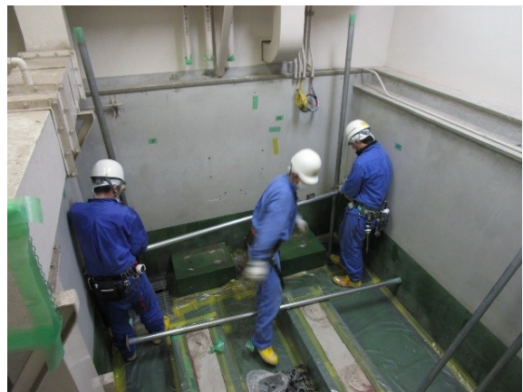
写真 2.1.3-1 廃液貯槽、配管撤去前後
