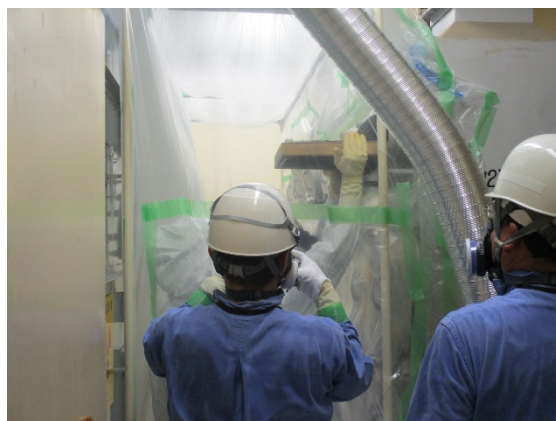
写真 2.1.7-2 フィルタ交換状況
