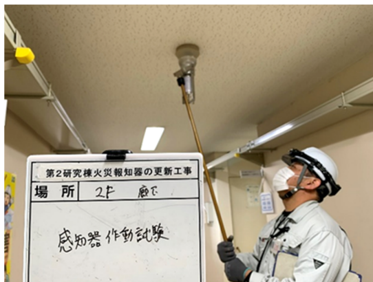
写真 2.10.2-3 第2研究棟 2階廊下 感知器作動試験
