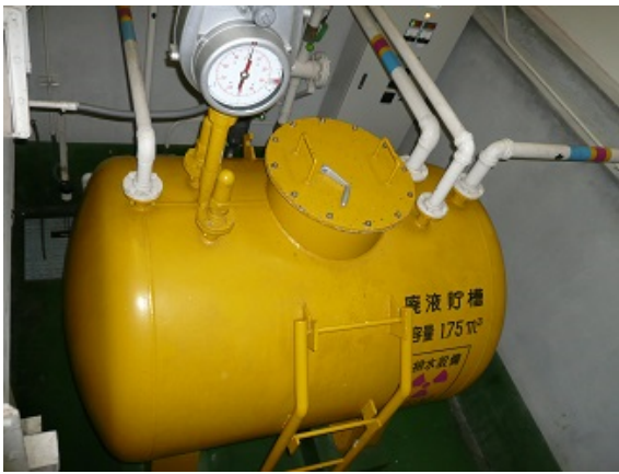
写真 2.1.3-1 廃液貯槽、配管撤去前後
