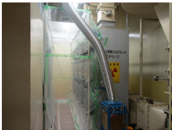
写真 2.1.7-1 グリーンハウス設置状況
