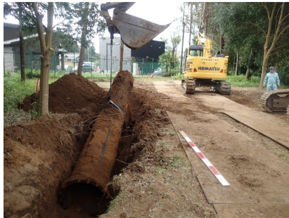
写真 2.10.5-1 導水管撤去状況
