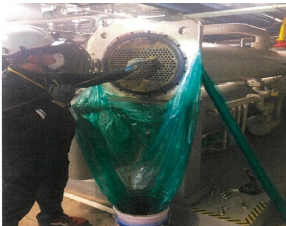
凝縮器洗浄状況
