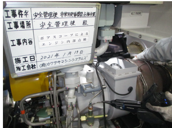
写真 2.1.14-2 ボアスコープによる内部点検
