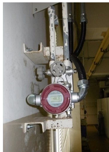
差圧発信器 更新後
