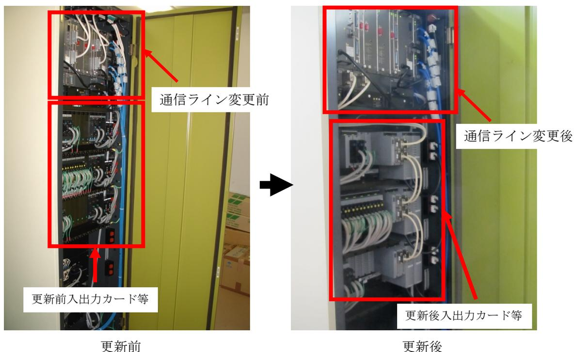
図 2.1.8 プロセス制御計算機入出力カード更新
