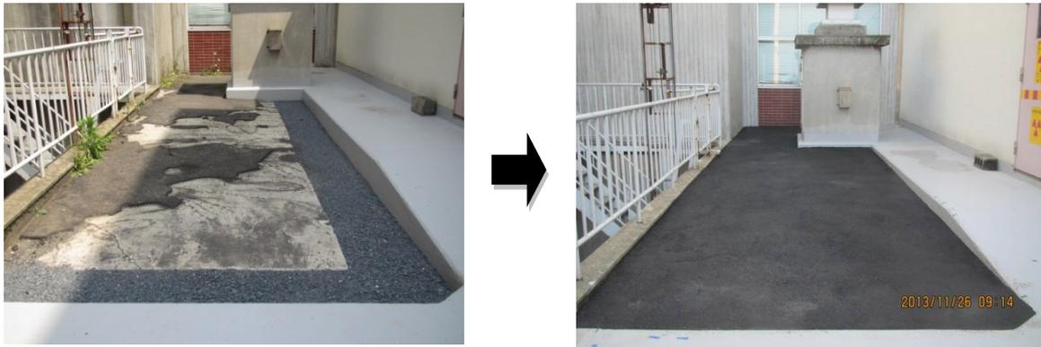
図 2.1.4 建家周辺アスファルト舗装の復旧状況
