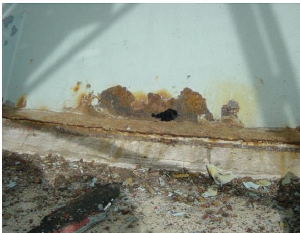
図 2.6.7 前回塗装時の貫通孔
