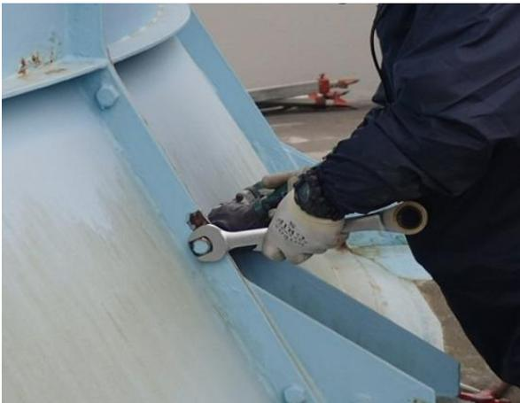
図 2.6.12 インパクトレンチによる取外し
