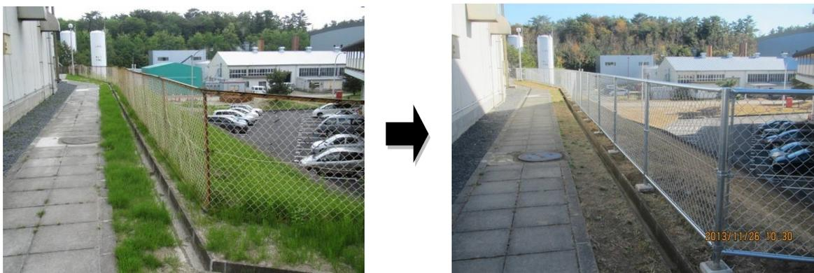
図 2.1.5 冷却塔フェンスの更新状況
