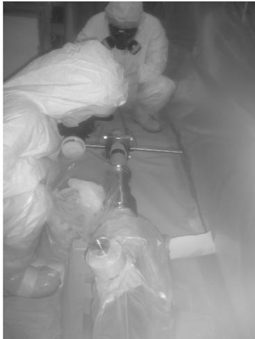
写真 3.3.1-1-3 安全棒装置の分解点検作業
