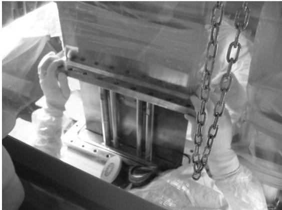
写真 3.3.1-1-1 安全棒装置の分解点検作業
