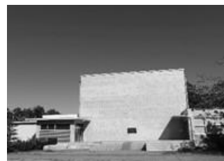
JRR-1 残存施設
