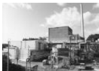
再処理特別研究棟
