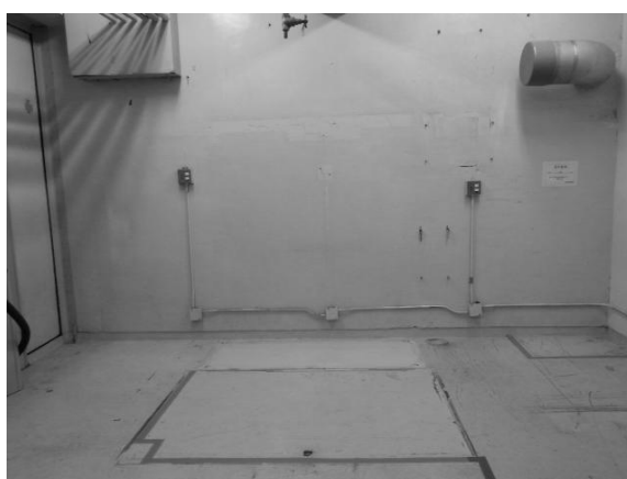
フード H-14 (解体後)
