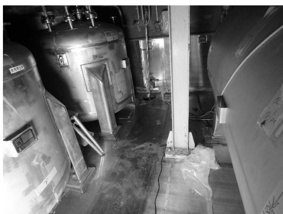
地下ピット廃液受槽 (MV-1、2、3) (解体前)
