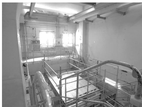
グローブボックス L (解体後)
