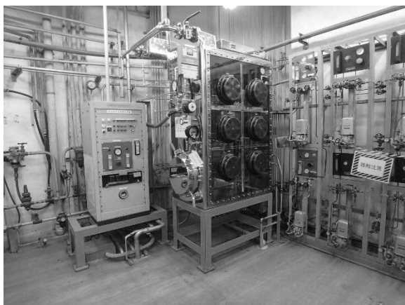
グローブボックス P (解体前)
