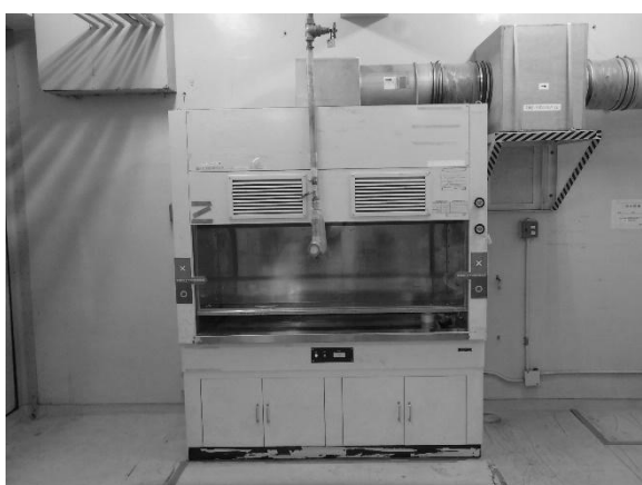
フード H-14 (解体前)
