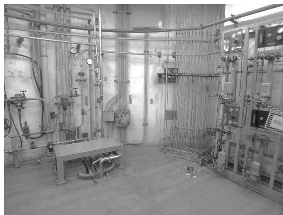
グローブボックス P (解体後)
