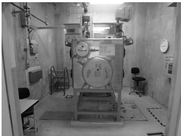
グローブボックス N (解体前)
