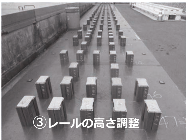
図 3.6.1-6 上屋移動用レール敷設作業の写真
