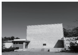
JRR-1 残存施設
