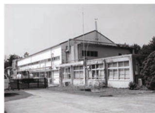
放射性廃棄物処理場 （液体処理場）
