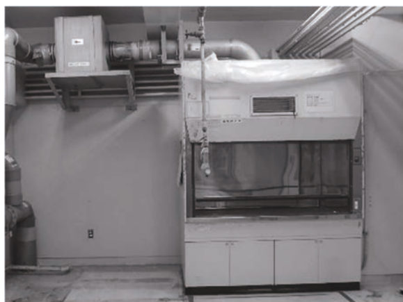
フード H-4（解体前）
