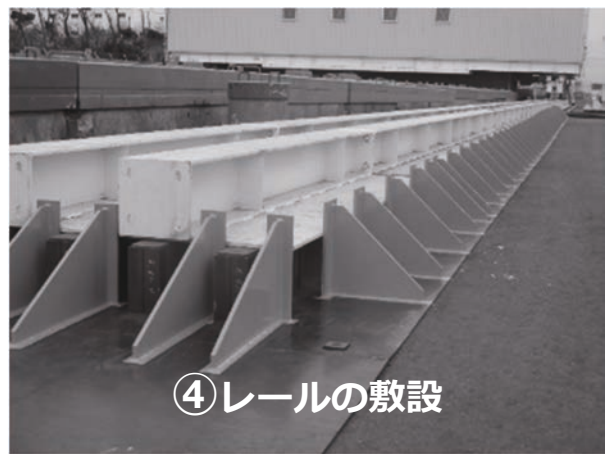
図 3.6.1-6 上屋移動用レール敷設作業の写真
