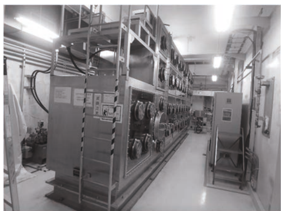
グローブボックス S（解体前）
