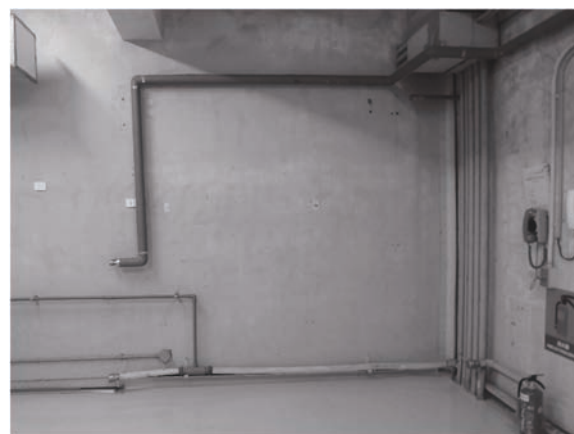
フード H-9（解体後）
