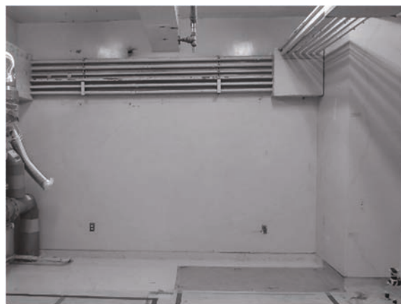
フード H-4（解体後）
