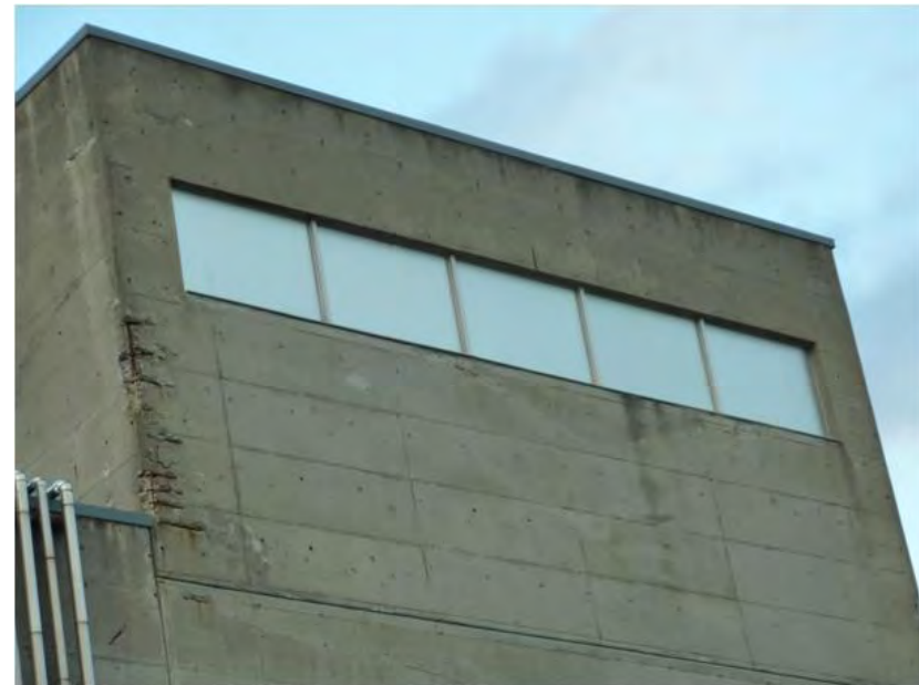
アルミ板設置による補修完了後
